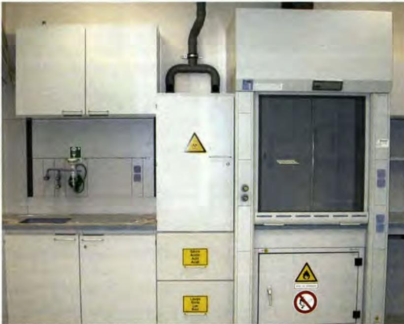
*Moderne Laboratorien sind High-Tech-Arbeitsplätze mit höchstem Anspruch an die Arbeitssicherheit. So umfassen die Sicherheitseinrichtungen in den Laboratorien standardmäßig u.a. Laborspüle mit Augendusche, Schrank für Gefahrenstoffe getrennt nach Giftstoffen, Säuren und Laugen sowie einen Abzug mit Unterbauschrank für brennbare Lösungsmittel (v.l.n.r.).*
