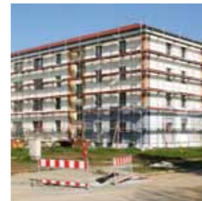
Auf dem Erweiterungsgelände für den Hubland-Campus laufen die Bauarbeiten auf Hochtouren.
