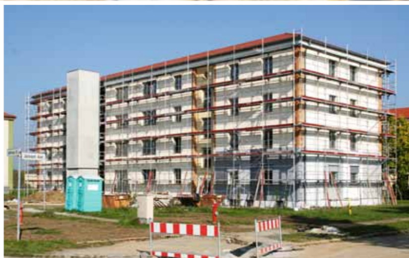
Arbeiten auf dem neuen Hubland-Campus
