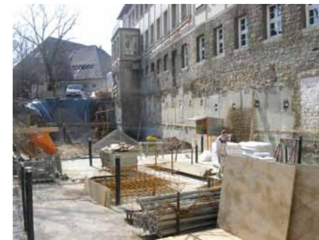
Saniert und modernisiert: das Institut für Hygiene und Mikrobiologie. Foto: Bauamt
