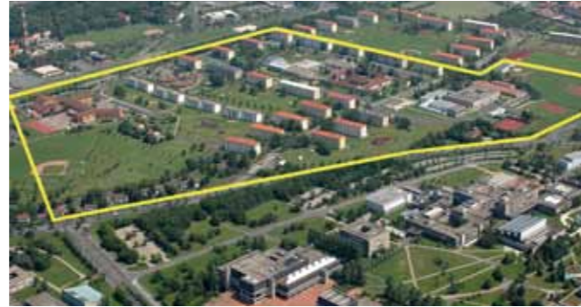
Das gelb umrandete Gebiet auf dem Leighton-Areal soll in den kommenden Jahren der Erweiterung der Universität dienen. Im Vordergrund der Hubland-Campus. Foto: Norbert Schwarzott
