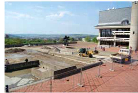
Die Sanierung des 8.000 Quadratmeter großen rot gepflasterten Platzes rund um Unibibliothek und Mensa begann im April 2009. Foto: Gunnar Bartsch
