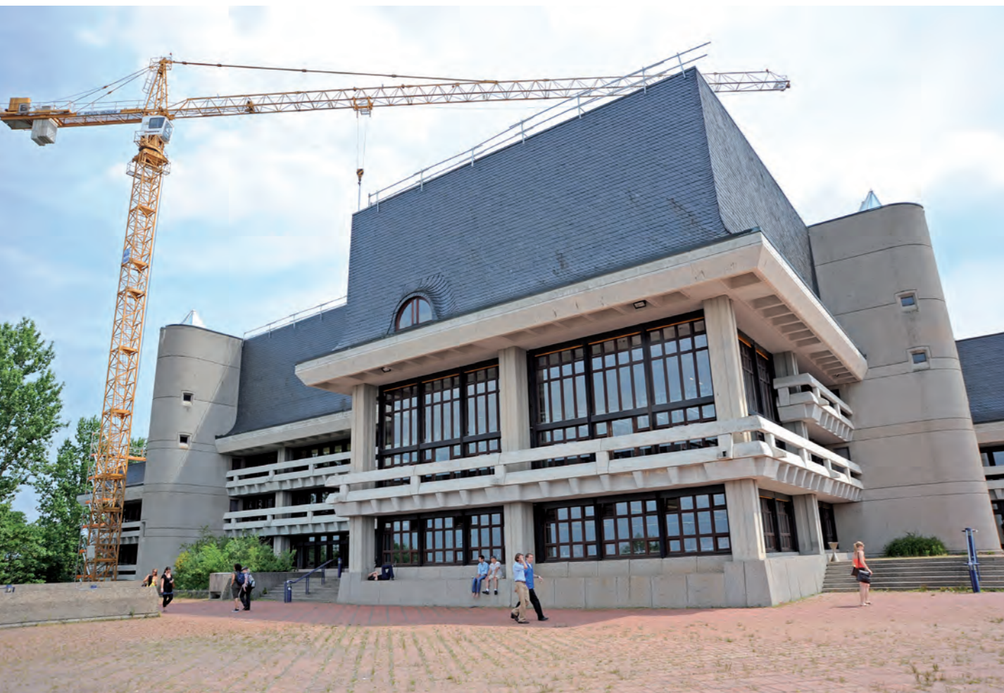
Bauarbeiten während der Dachsanierung der UB
