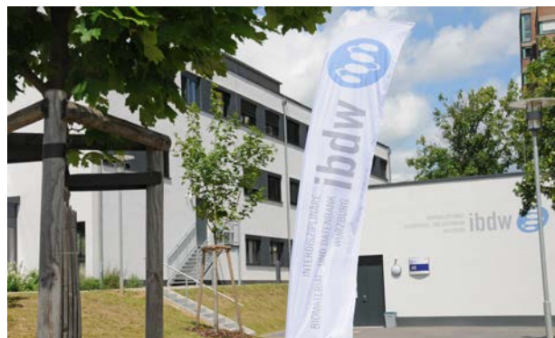
Der Neubau für die Interdisziplinäre Biomaterial- und Datenbank (ibdw) in Würzburg. (Foto: Robert Emmerich)
