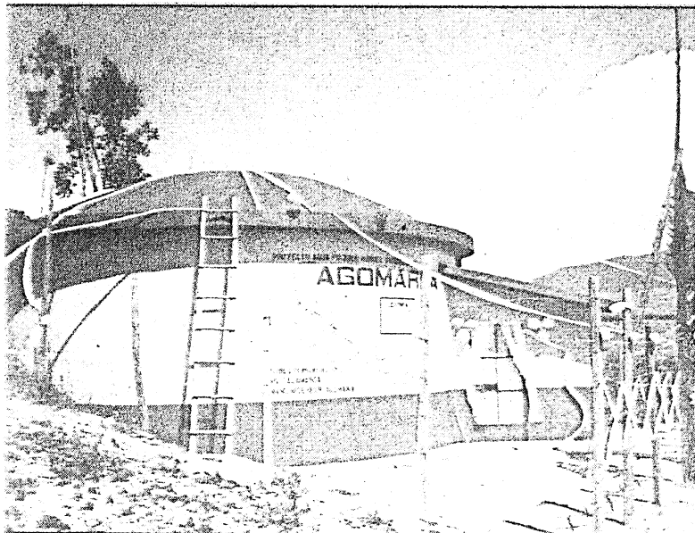
RESERVOIRIO DE AGUA POTABLE AGOMARCA - BAMBAMARCA
