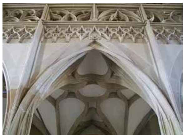
Bad Königshofen, Kirche Mariä Himmelfahrt: Detail der repräsentativen Westempore mit sphärisch verlaufenden Bogenprofilen und modernem Schlingrippengewölbe. (Bild: Stefan Bürger / Universität Würzburg)
