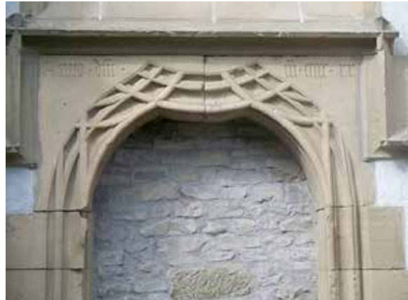
Hohenfeld, Bergkirche: Vorhangartiger Bogen einer zuge-setzten Chorpforte mit reichen Profilierungen und Durchsteckungen samt Bauinschrift. (Bild: Stefan Bürger / Universität Würzburg)
