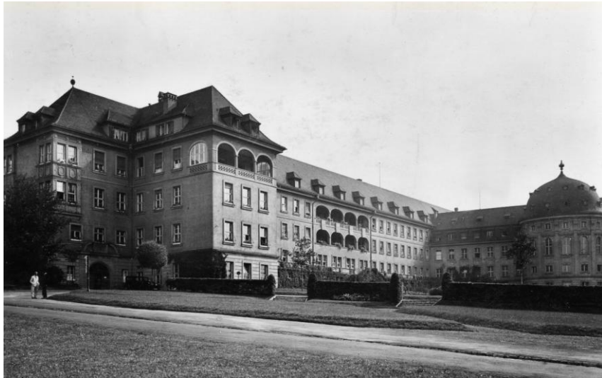
Die abgebildete Postkarte zeigt die neu gebaute Universitätsklinik Luitpoldkrankenhaus im Bauzustand gegen Ende der 1920er Jahre.
